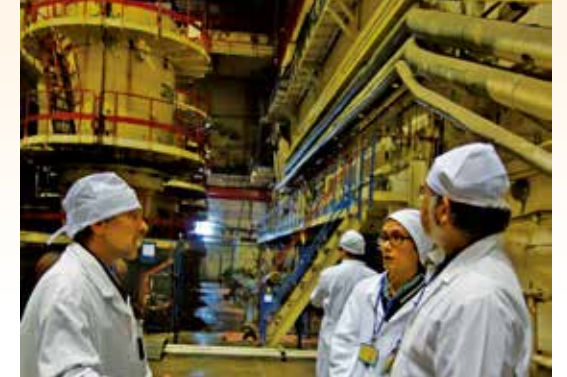
ドーム建設中の3号炉とその内部
