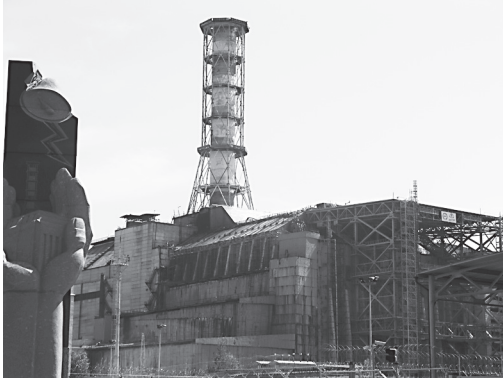
1986年4月26日事故を起こしたチェルノブイリ4号炉 事故後炉を覆うために作られた石棺も老朽化が進む
