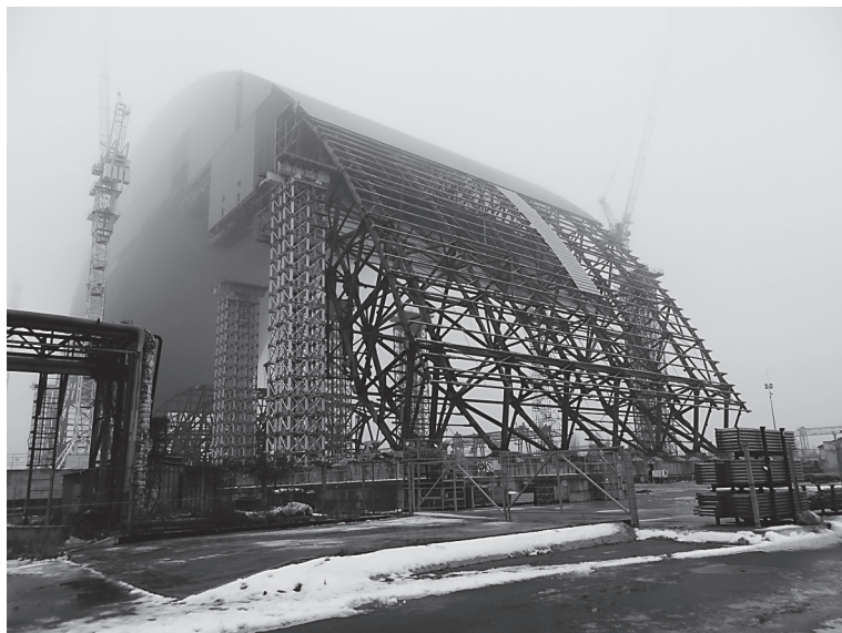
チェルノブイリ原発4号炉を覆うために建設中のドーム
