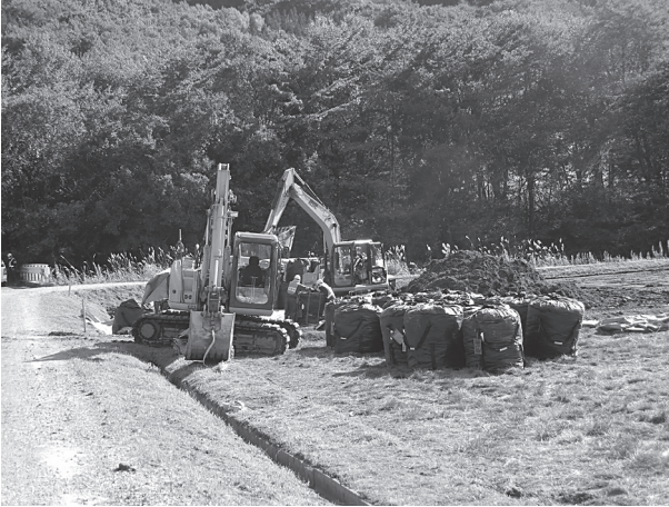
重機で除染した土が、フレコンバッグに詰められて並ぶ
