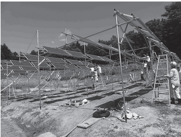
ソーラーパネルの設置工事
