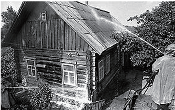
ベラルーシでの建物の除染
